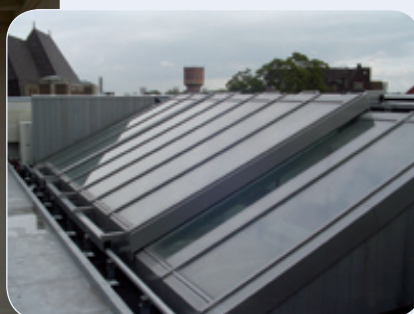
De Tuinzaal in bouwfase
