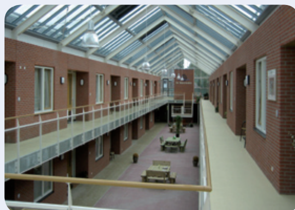
Het zadeldak van 52 x 9 meter vormt de centrale ruimte tussen de 27 aanleunwoningen
