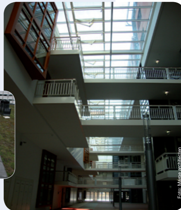
Daglicht komt binnen via een glazen lessenaardak met isolerende, zonwerende beglazing en via twee glazen gevels.
